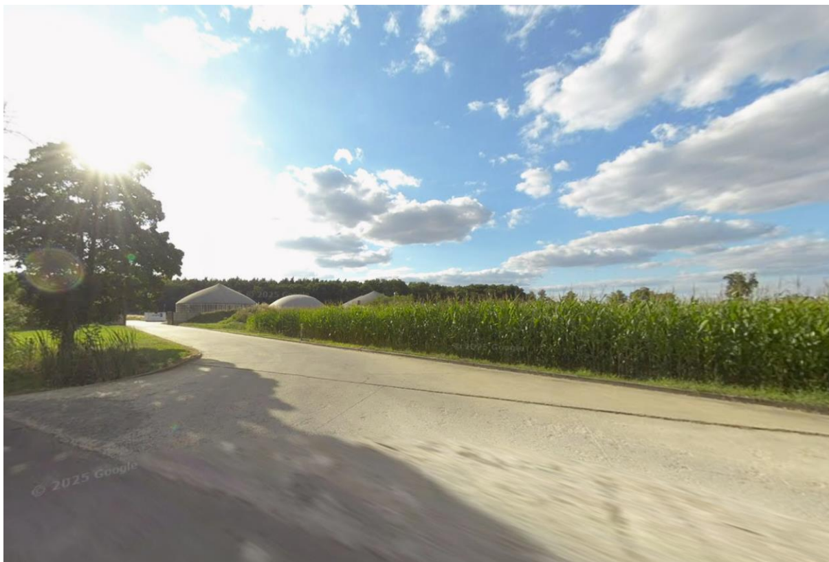
Fot. 5 Istniejąca biogazownia
