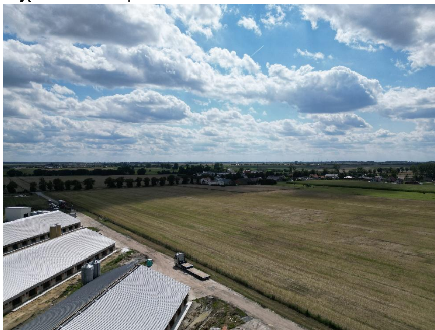
Zdjęcie 6 - Strona południowo-zachodnia
