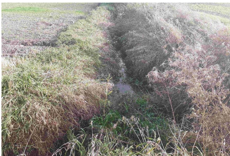
Fot.4. Przebieg drogi koliduje z kilkoma niewielkimi ciekami wodnymi.
