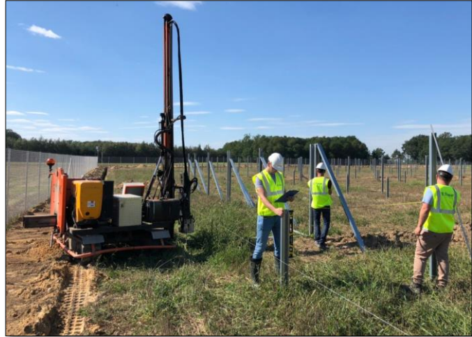
Zdjęcie 4 Montaż konstrukcji wsporczej
