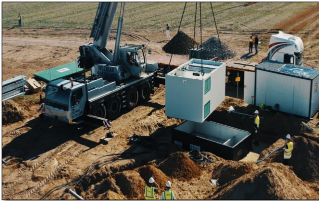
Zdjęcie 7 Stacja transformatorowa - montaż
