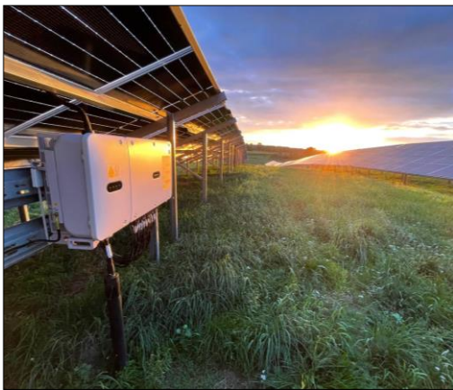
Zdjęcie 5 Inwerter – montaż na konstrukcji
