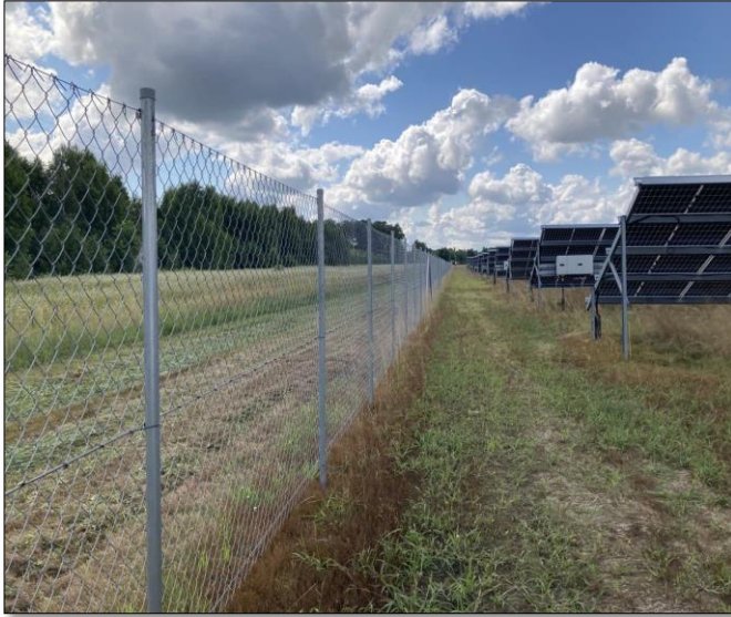
Zdjęcie 10 Ogrózenie terenu inwestycji
