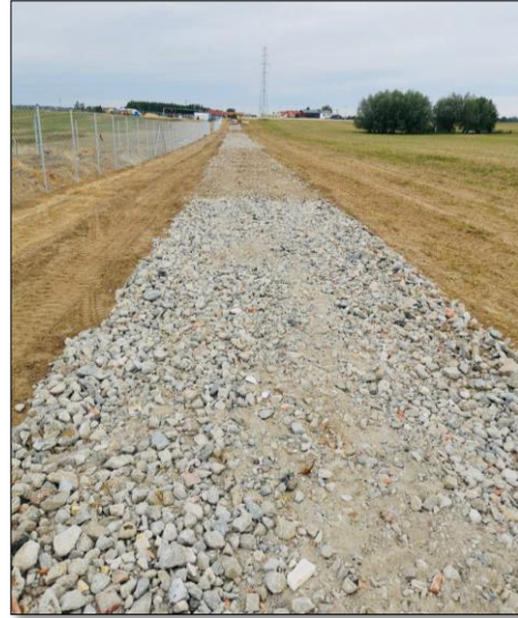
Zdjęcie 11 Droga wewnętrzna
