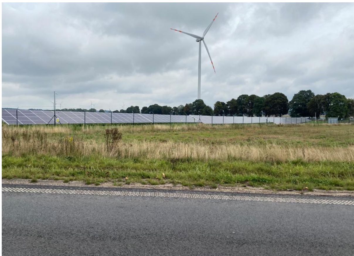
Fot. 1 Zdjęcie istniejącej farmy fotowoltaicznej na tle elektrowni wiatrowej.
