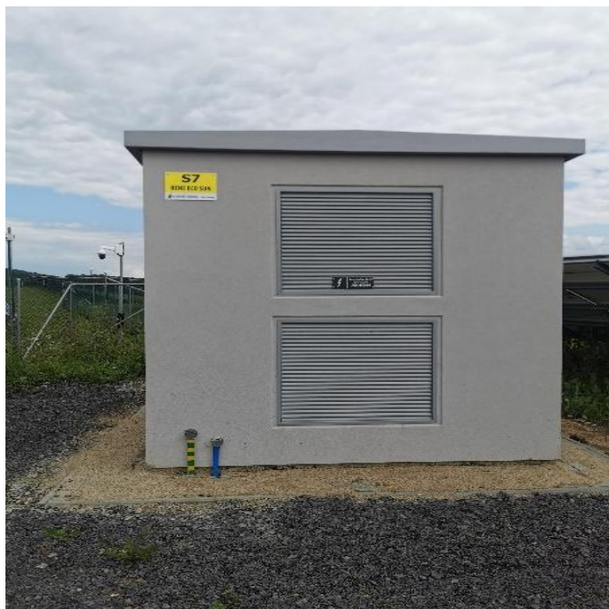
Rysunek 9. Przykładowy budynek kontenerowej stacji transformatorowej.
