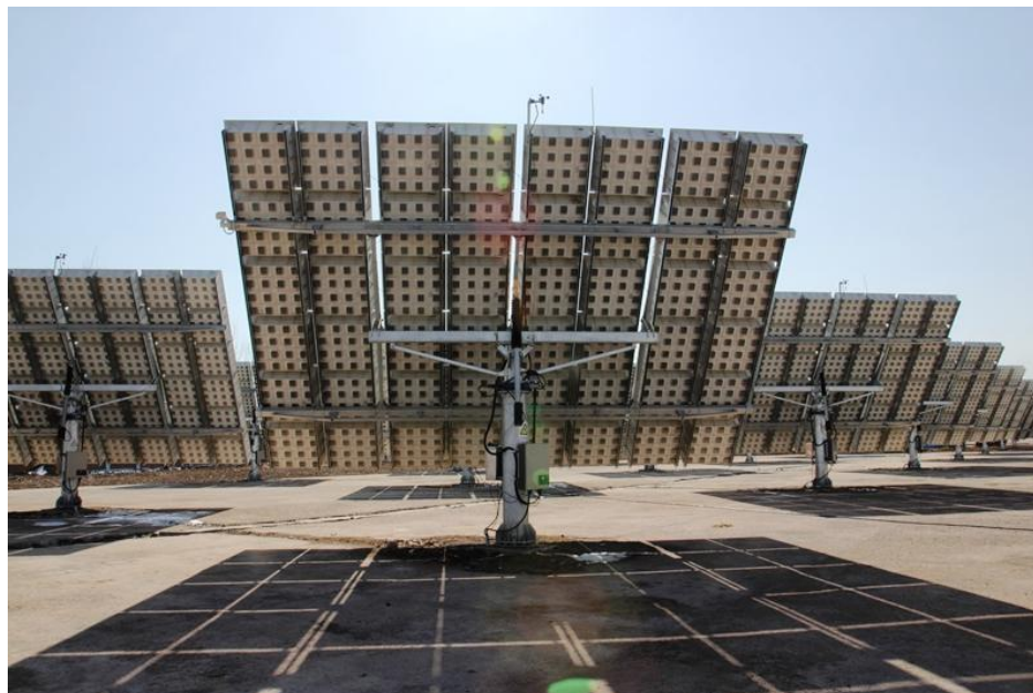
Rysunek 10. Przykładowe panele z systemem trakcyjnym typu „dual axis”.
