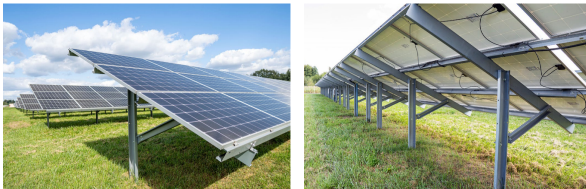
Rys. 3.5. Przedstawienie przykładowych konstrukcji pod panele fotowoltaiczne
