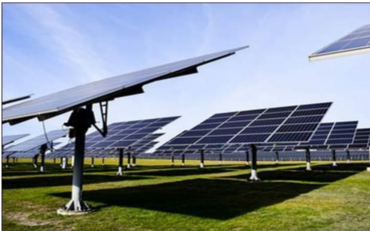
Rycina 5. Konstrukcja śledząca ruch słońca przeznaczona do posadawienia paneli fotowoltaicznych.
