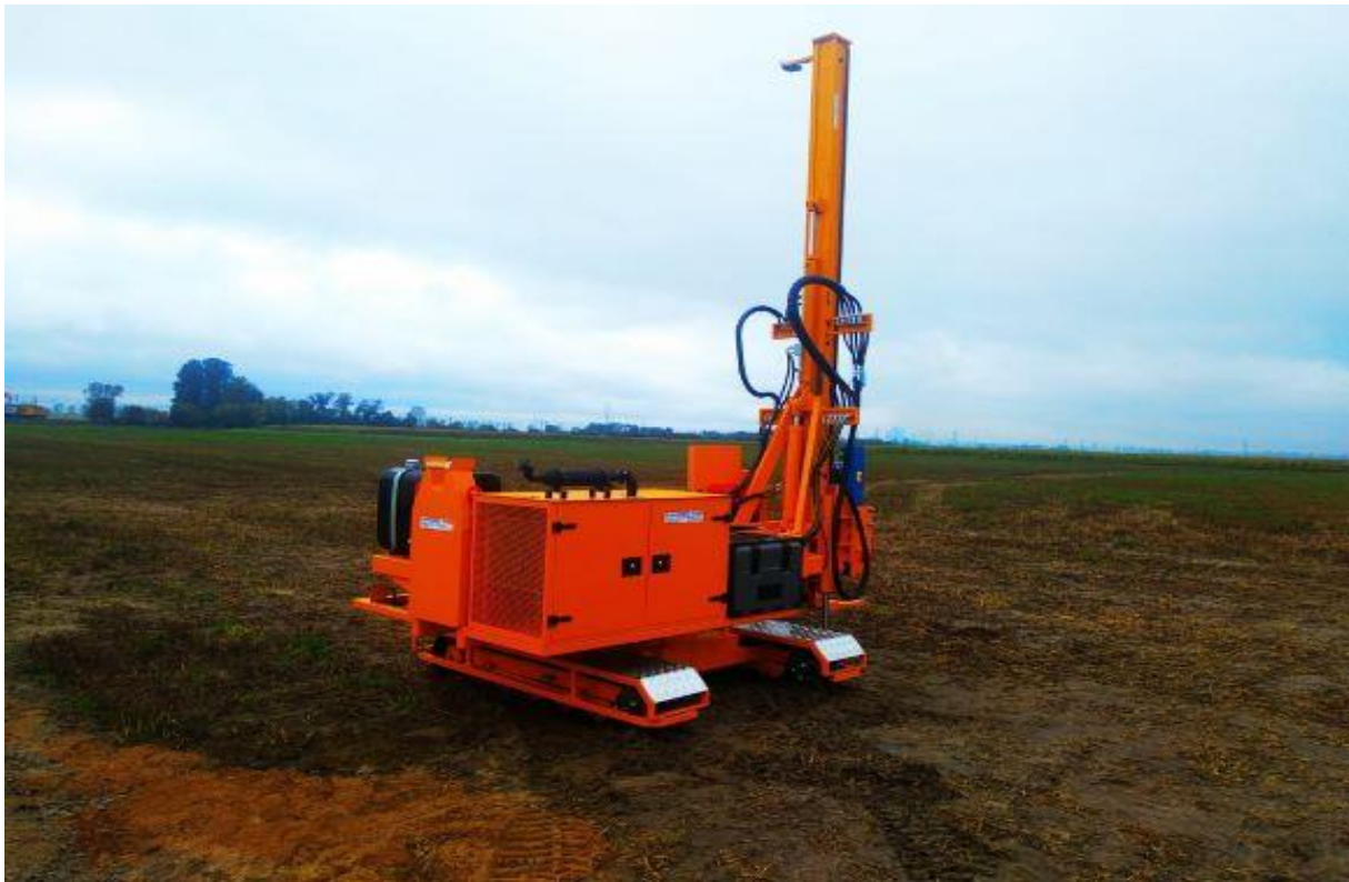
Rycina 3. Budowa konstrukcji za pomocą kafara.
