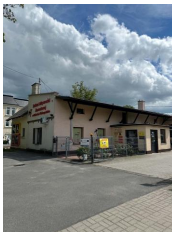
Zdjęcie 7. Zakład Aktywności Zawodowej w Koźminie Wielkopolskim
