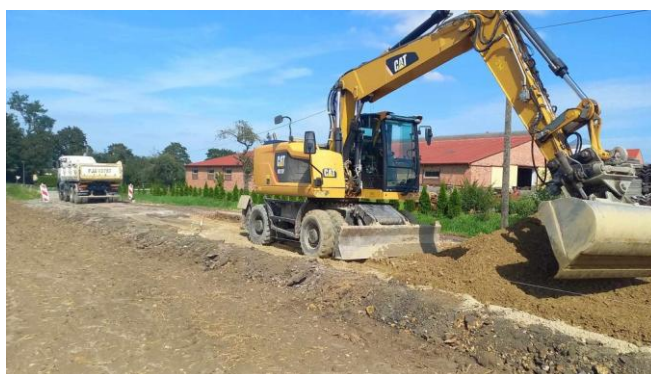
Budowa drogi w Tatarach
